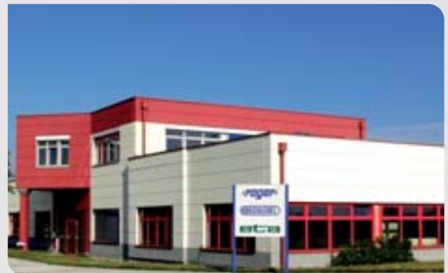
Firmengebäude Schlegel Vertriebs Ges.mbH, Österreich
