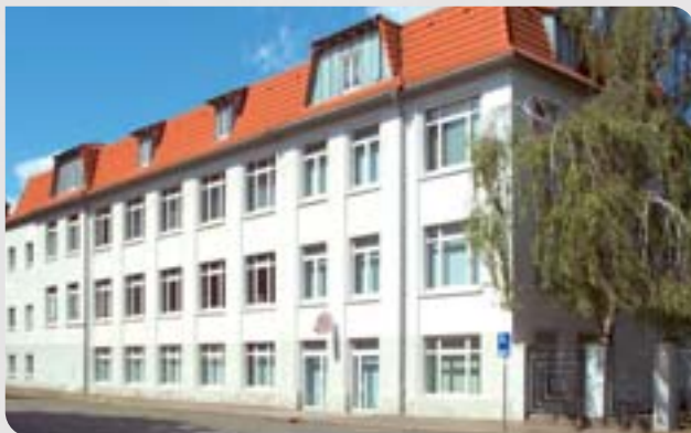
Firmengebäude Schlegel Elektrokontakt GmbH, Leipzig
